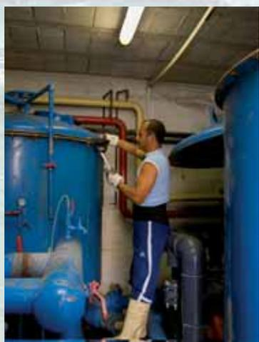
Ali est agent technique. Il est en charge de la maintenance des installations techniques, tels que les appareils de traitement des eaux ou la chaufferie. Il est notamment chargé d'injecter le chlore qui permet de désinfecter l'eau du bassin.
