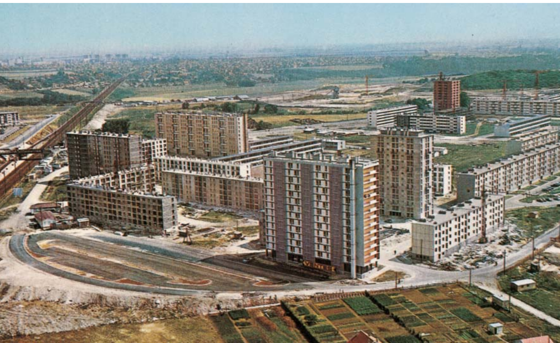
La construction de Dame Blanche dans les années 1960.
