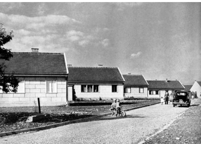
Nouveaux pavillons construits en 1954.
