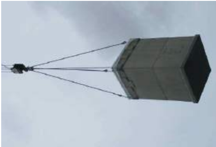
4 prises extérieures situées à 60 cm du dessus du conteneur servent à la fixation des élingues sur le béton
